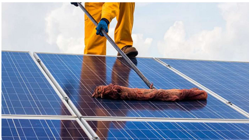
Σχήμα 55. Χειροκίνητος καθαρισμός πάνελ
