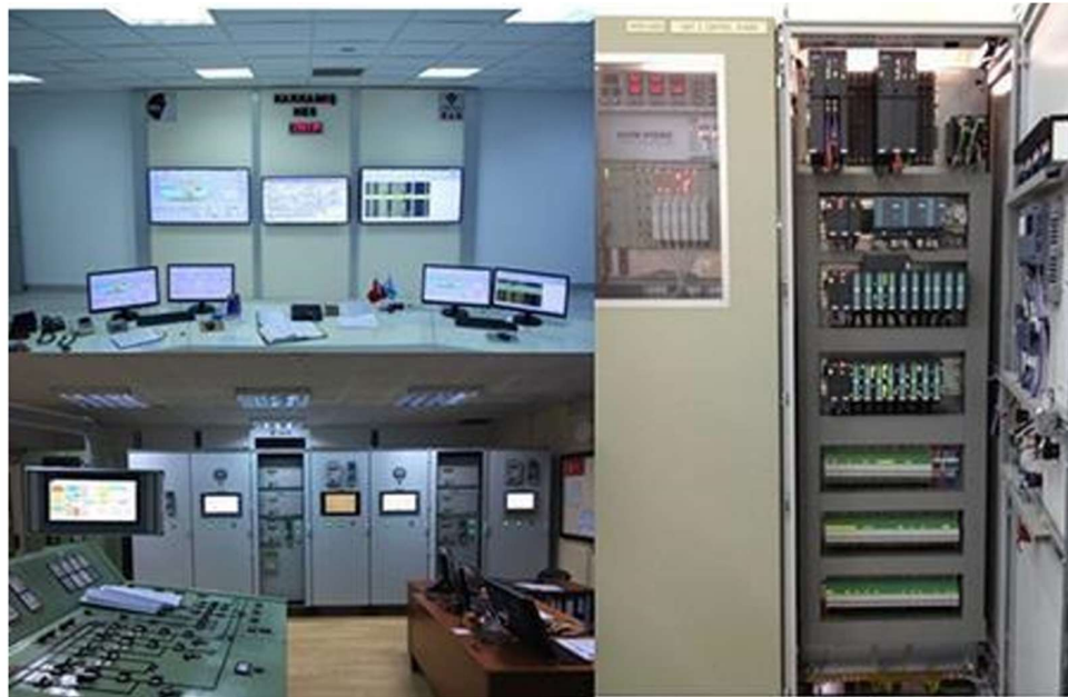
Σχήμα 76. Σύστημα ελεγχόμενο από SCADA [112]
